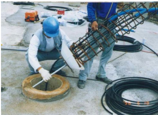
写真-6.3 杭内部への配管（県立音楽堂）
