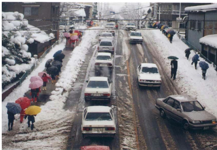
写真-4.1 歩道無散水と車道散水をセットにした融雪 (右側未施工)
