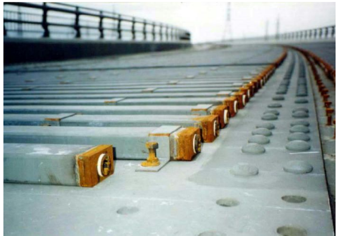
写真-11.2 潜熱蓄熱材封入鋼管の設置
