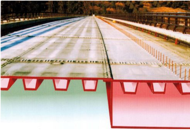
写真-9.7 未舗装閉断面リブ鋼床版の結露
