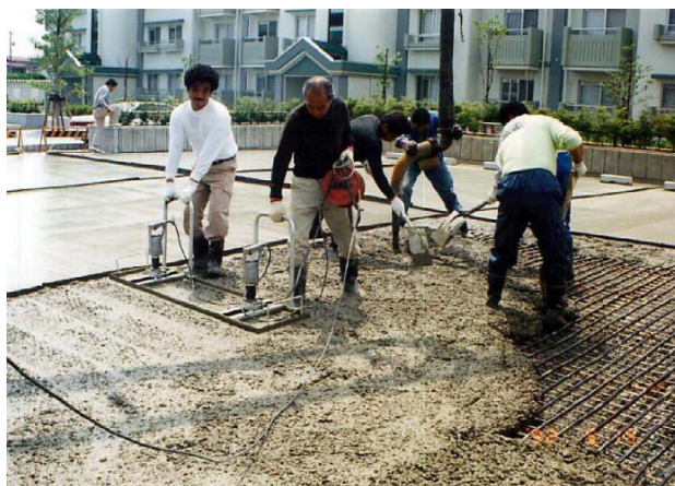
写真-6.4 放熱管の上での舗装の施工（福井県立大学職員住宅駐車場）
