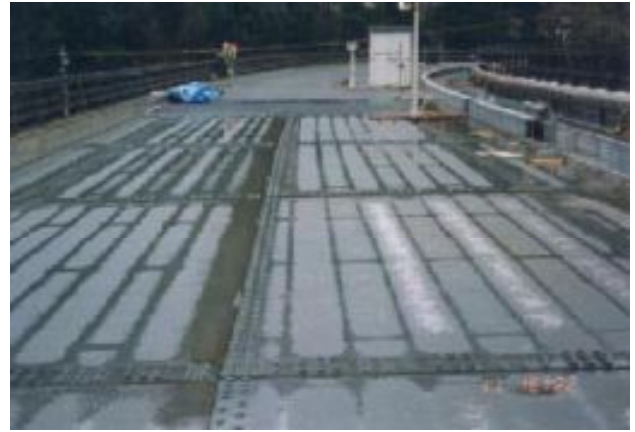
写真-9.8 未舗装閉断面リブ鋼床版での自然融雪
