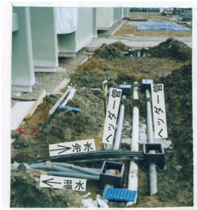
写真-6.1 杭からのポリエチレン管とヘッダー管
