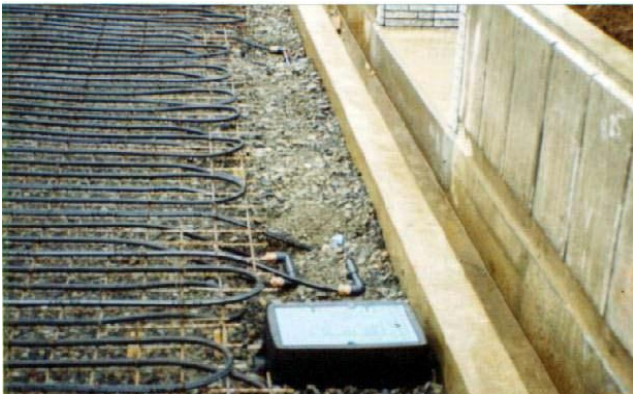
写真-2.5 クロス配管（県立大学職員住宅駐車場）
