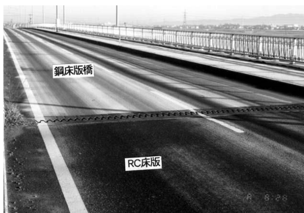
写真-9.1 鋼床版橋とRC床版の結露凍結の違い
