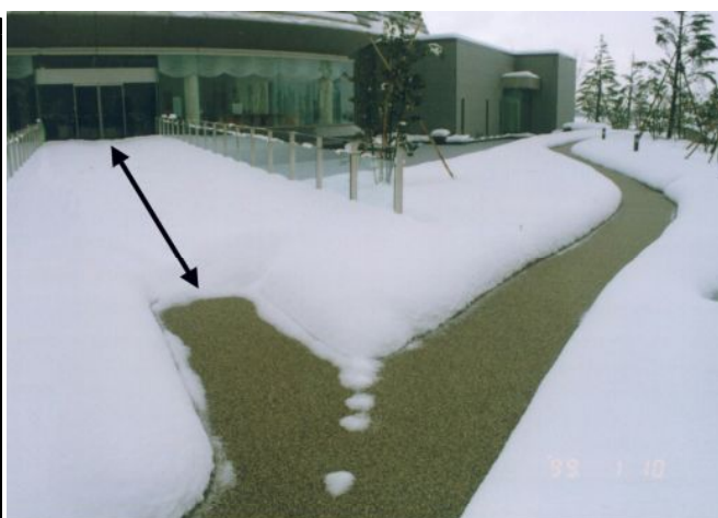
写真-2.7 放熱管は矢印の区間にも続いて埋設されているが、放熱管が深くに埋設され、手前の舗装のような高熱伝導舗装でないため、雪は溶けない。
