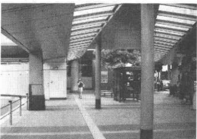
バスターミナルの駅前広場から駅ビルへは屋根付きの歩道が設けられていて傘をさす必要がない。
