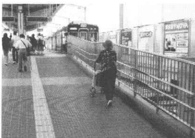
阪急伊丹駅のプラットフォームに続く緩やかなスロープ。車椅子や歩行器の人を考慮して高さの異なる二つの手すりも設置されている。
