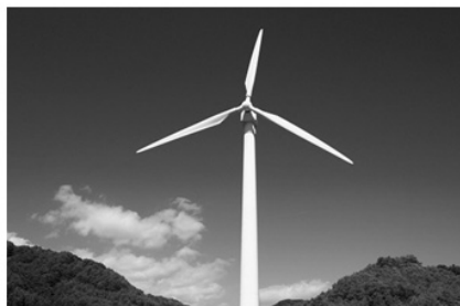
図2 水平軸プロペラ型風車
