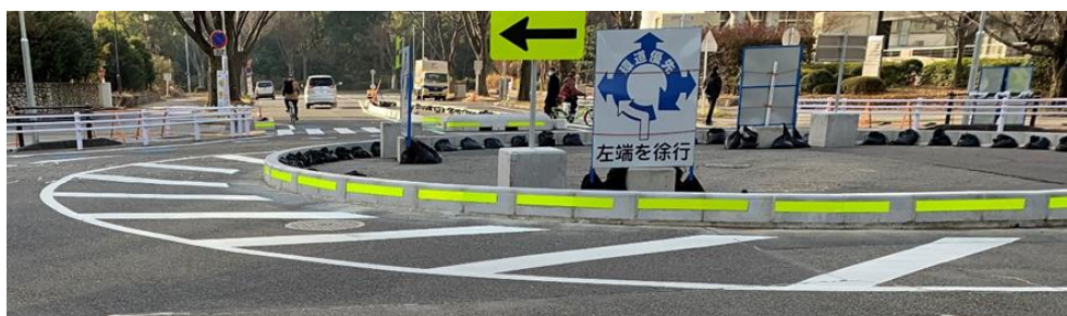
図 3-5 エプロンの施工状況
