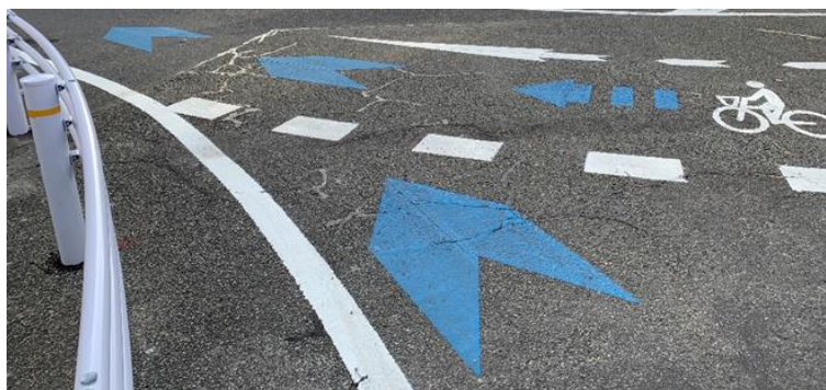
図 3-7 環道流入部付近の矢羽根の施工状況
