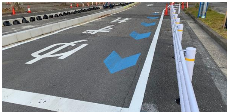
図 3-6 流入部の矢羽根の施工状況
