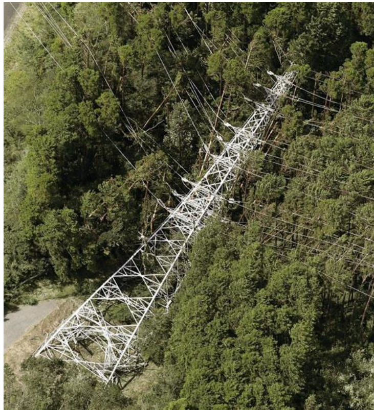
写真 1.1-1 木内線倒壊事故 1.6)
