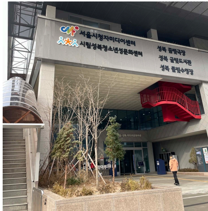
Fig. 3.19: ソウル市役所メディアセンター・市立城北青少年城文化センターの外観 筆者撮影
