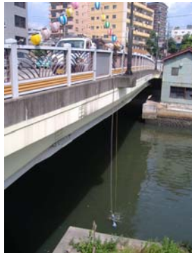
302 川底微生物牧場エサ係員 雨水等を貯水して川底にパイプで流し込み微生物の働きで水をきれいにしてもらう
