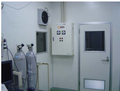
写真 1 : クリーンルーム
