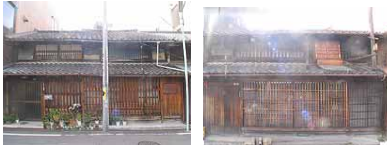
写真5.2 建物正面写真（左側と右側）
