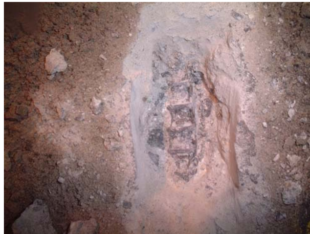
写真6-2 床版Ⅰ「損傷部」で-283mVvs.CSEを示した箇所の鉄筋の状態
