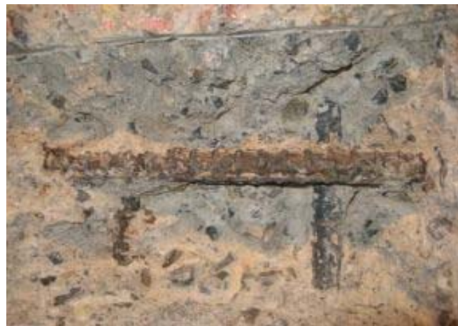
写真6-5 床版Ⅱ「健全部D」で-440mVvs.CSEを示した 箇所の鉄筋の状態
