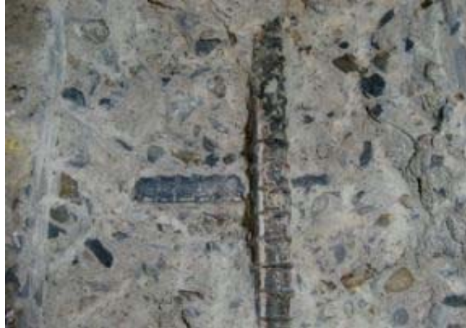
写真6-3 床版Ⅱ「健全部A」で-451mVvs.CSEを示した 箇所の鉄筋の状態
