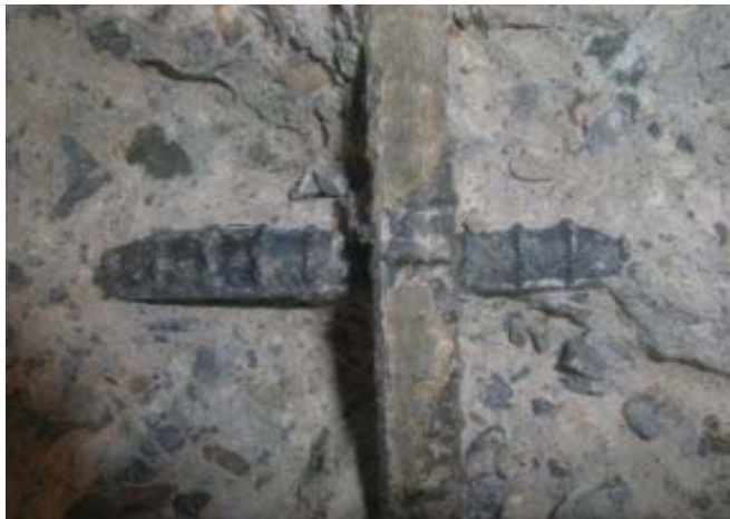
写真6-4 床版Ⅱ「損傷部C」で-518mVvs.CSEを示し た箇所の鉄筋の状態
