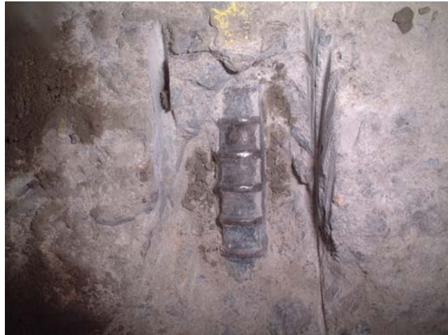
写真6-1 床版Ⅰ「健全部」で-121mVvs.CSEを示した箇所の鉄筋の状態
