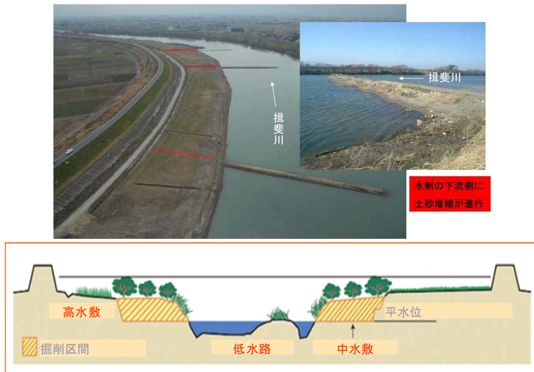
図-1.2 揖斐川の水制と掘削工事
