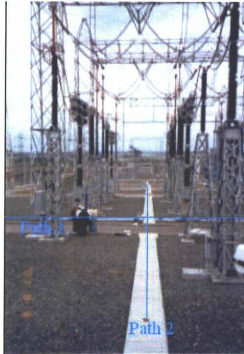
図 4-10 図 4-8 および 4-9 で示した 500 kV 変電所内の定点測定の測定パス Fig. 4-10 Spot measurement paths in a 500-kV substation shown in Figs. 4-8 and 4-9.
