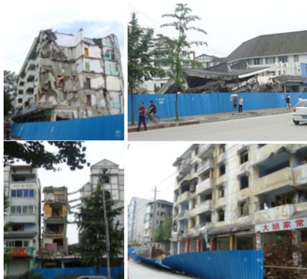
図2-11 市内の住宅の被害写真 (2008年8月現地調査より)
