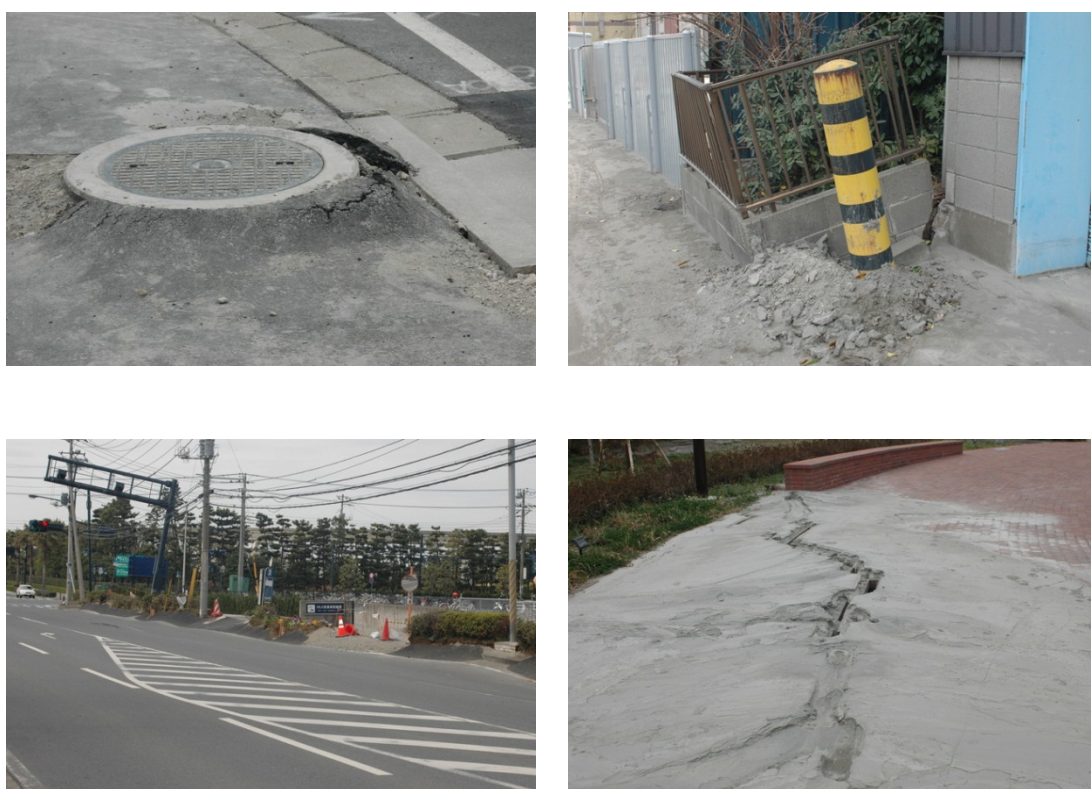
Fig. 6.1.1 液状化による被害
