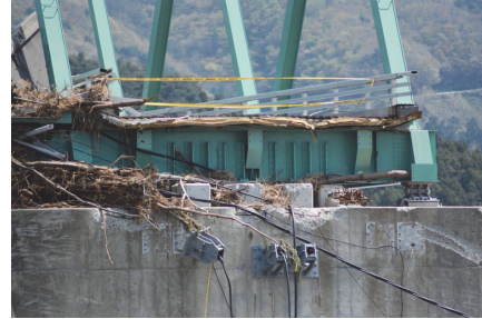
写真-1.8 津波による上部工流出(新北上大橋)
