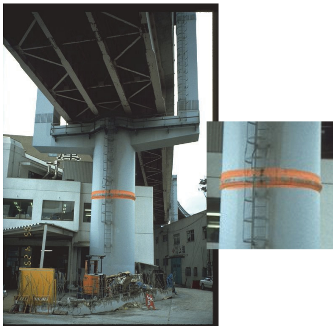
写真-1.5 円形断面鋼製橋脚の提灯座屈(浜手バイパス)
