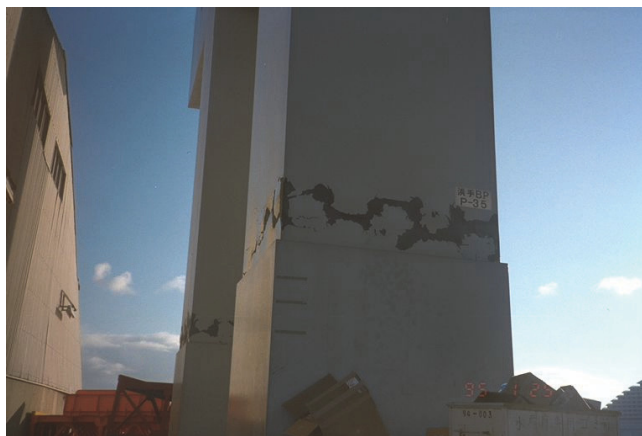
写真-1.4 矩形断面鋼製橋脚の局部座屈(浜手バイパス)
