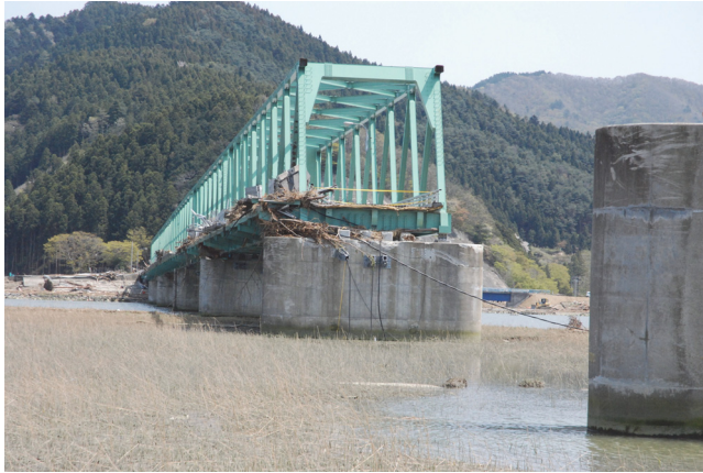
写真-1.8 津波による上部工流出(新北上大橋)
