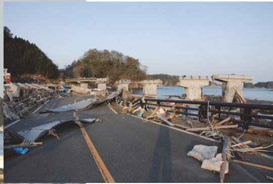
写真-1.9 津波による上部工流出(歌津大橋)
