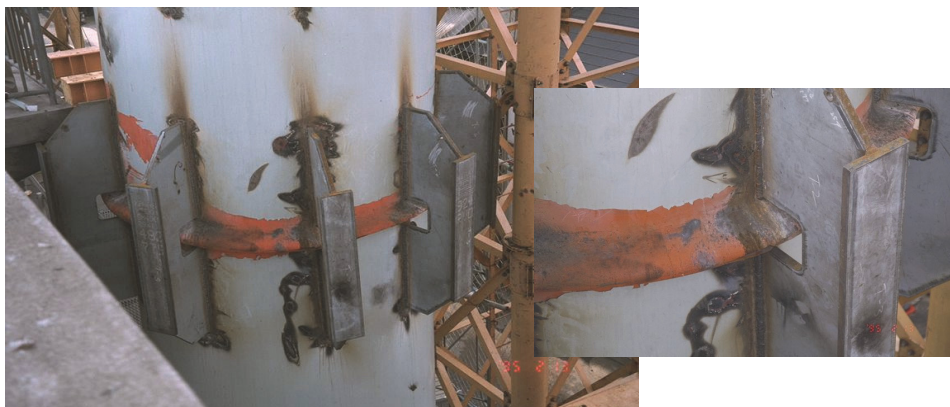
写真-1.6 円形断面鋼製橋脚の提灯座屈(阪神高速神戸線)
