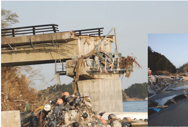
写真-1.8 津波による上部工流出(新北上大橋)
