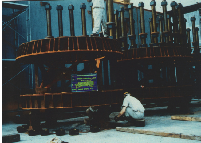
補図-1.2 杭方式のアンカーフレームと固定治具の写真
