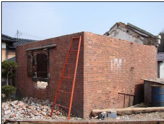
写真-5.3.8 同文庫解体中
