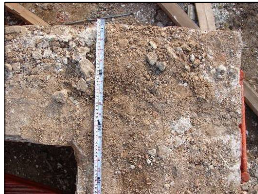
写真-5.3.9 壁直交部の断面
