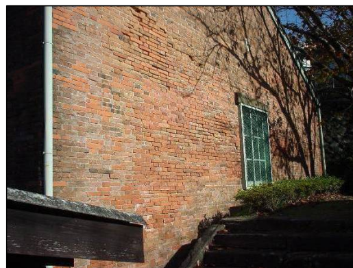
写真・1.1.2 小菅ドック捲上げ機小屋
