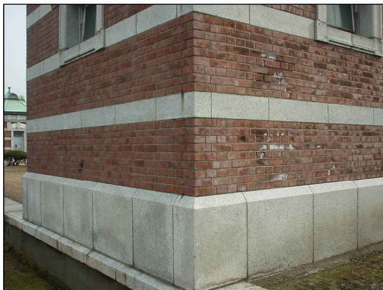
写真-5.4.2 旧整水室上屋の背面と側面の壁
