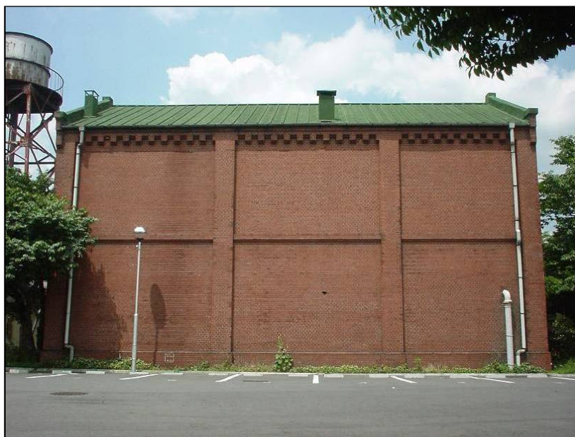
写真-6.3.3 A構面（東面）
