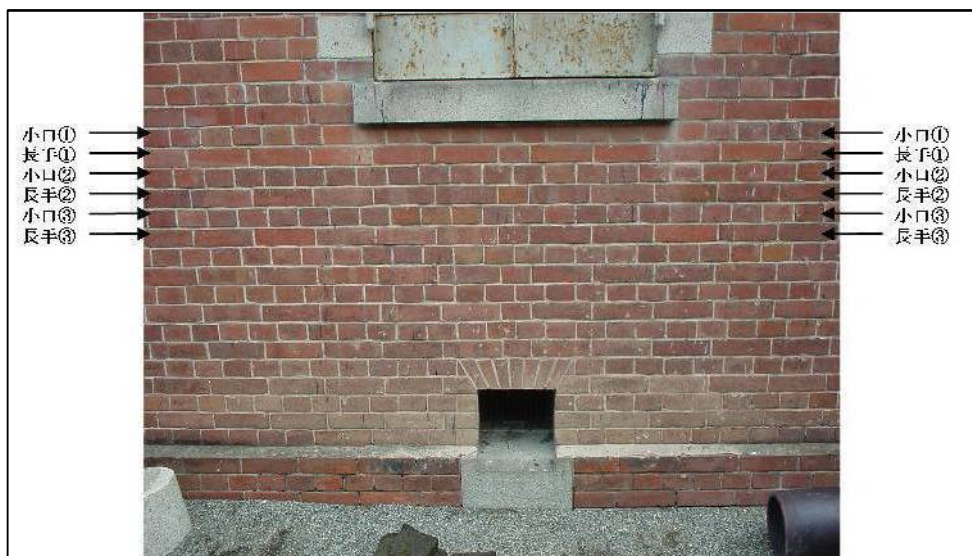
写真・4.2.1 妻面における水平方向の調査箇所
