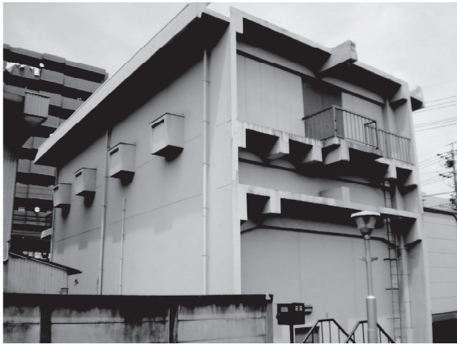
写真1 屋内変電所外観
