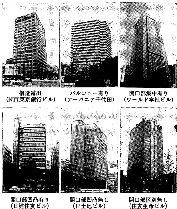
写真1 実験対象建物
