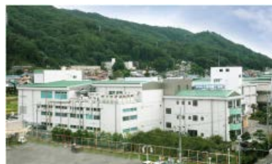
本社工場全景（同社提供）
