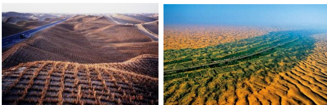
図 11 鉄道沿いの草方格砂漠化防止プロジェクト
