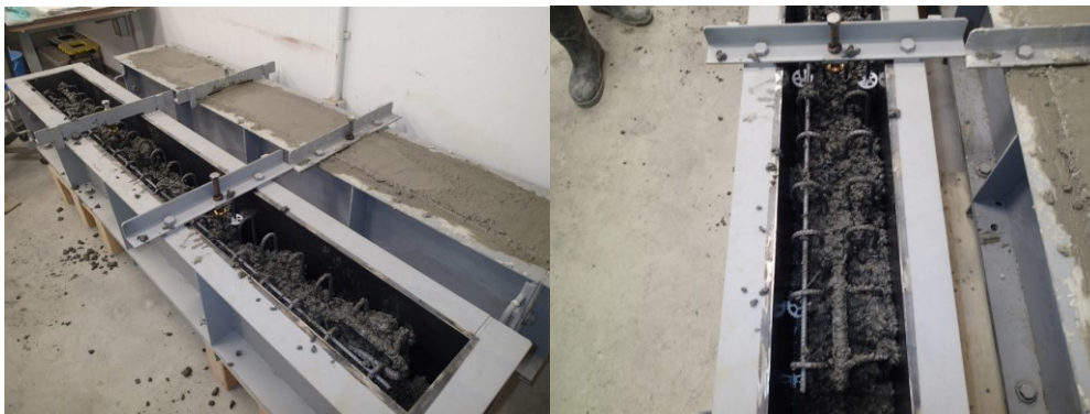
写真 4-1 供試体の鉄筋配筋状況 1
