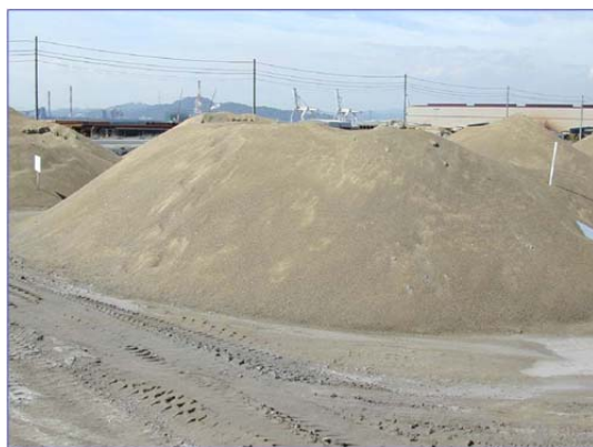
写真 2.2 高炉スラグ細骨材の貯蔵状況 4)
