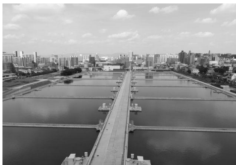
緩速ろ過池（鍋屋上野浄水場）
