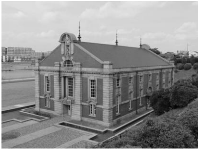
旧第一ポンプ所（鍋屋上野浄水場）
