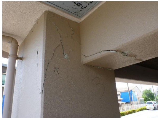
図 1-2-6 熊本地震（2016）のピロティ建物の被害事例⑤ 19)
