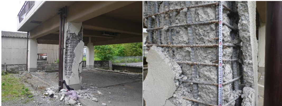
図 1-2-4 熊本地震（2016）のピロティ建物の被害事例③ 19)
