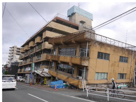
図 1-2-9 熊本地震（2016）のピロティ建物の被害事例⑧ 19)
