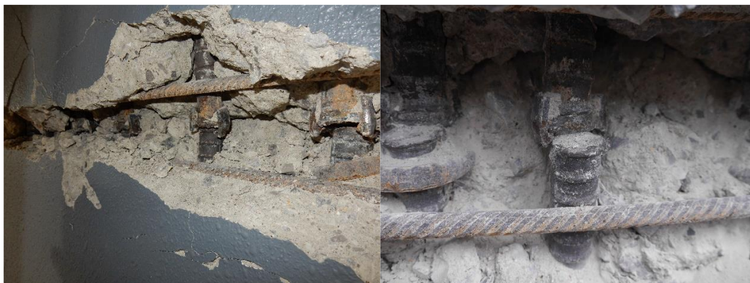
図 1-2-3 熊本地震（2016）のピロティ建物の被害事例② 19)
