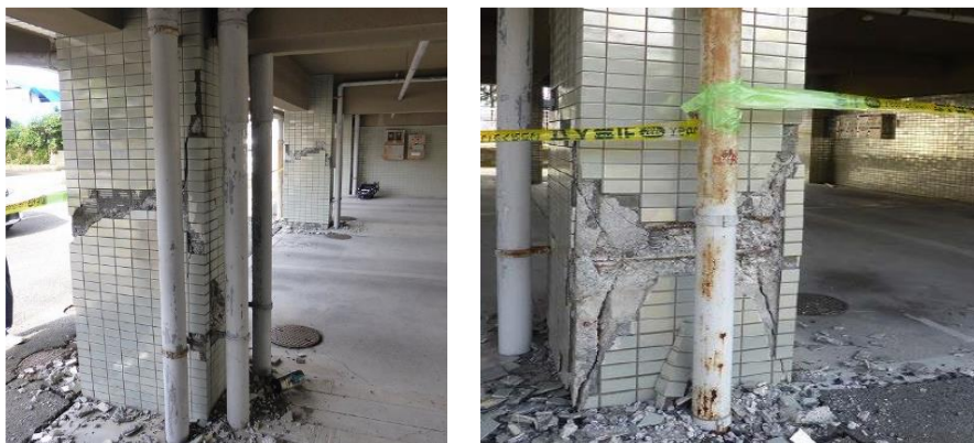
図 1-2-7 熊本地震（2016）のピロティ建物の被害事例⑥ 19)
