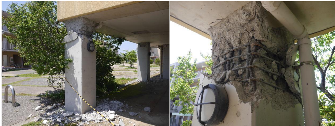
図 1-2-2 熊本地震（2016）のピロティ建物の被害事例① 19)
