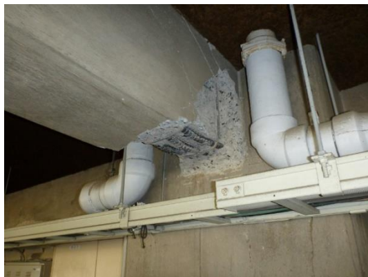
図 1-2-5 熊本地震（2016）のピロティ建物の被害事例④ 19)
