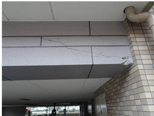
図 1-2-8 熊本地震（2016）のピロティ建物の被害事例⑦ 19)
