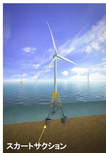
図 1.2 洋上風車への適用イメージ (左: モノバケツトタイプ, 右: ジャケツトタイプ)
