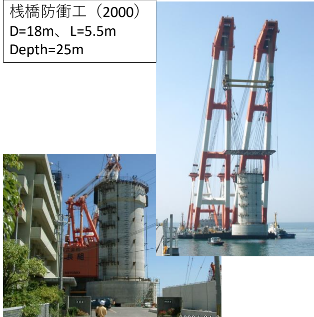
写真 1.2 大阪府岬町土砂採取栈橋防衝工 (RC 製)
