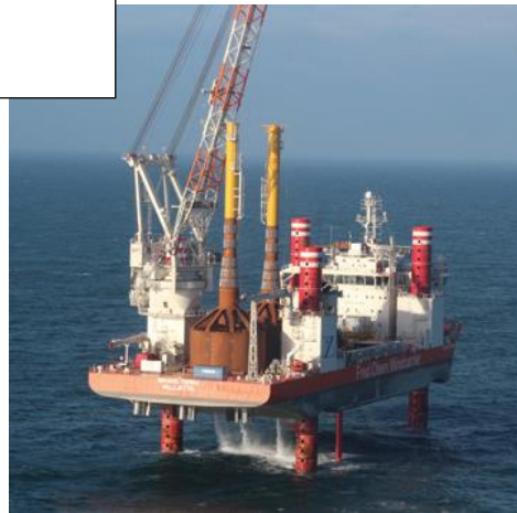
写真 1.4 モノバケットタイプ観測タワー基礎
