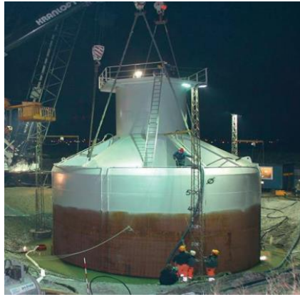
写真 1.3 モノバケットタイプ風車基礎（鋼製）
