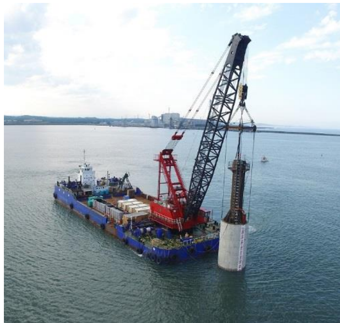
写真 2.2 FC 船による吊り曳航
