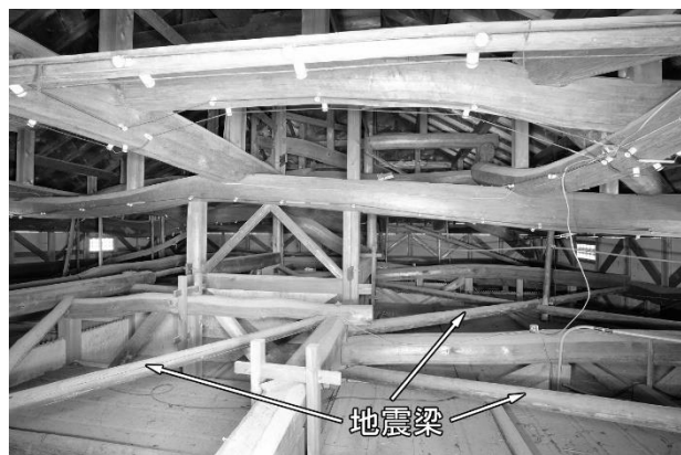
写真 2-5 天井上の地震梁
