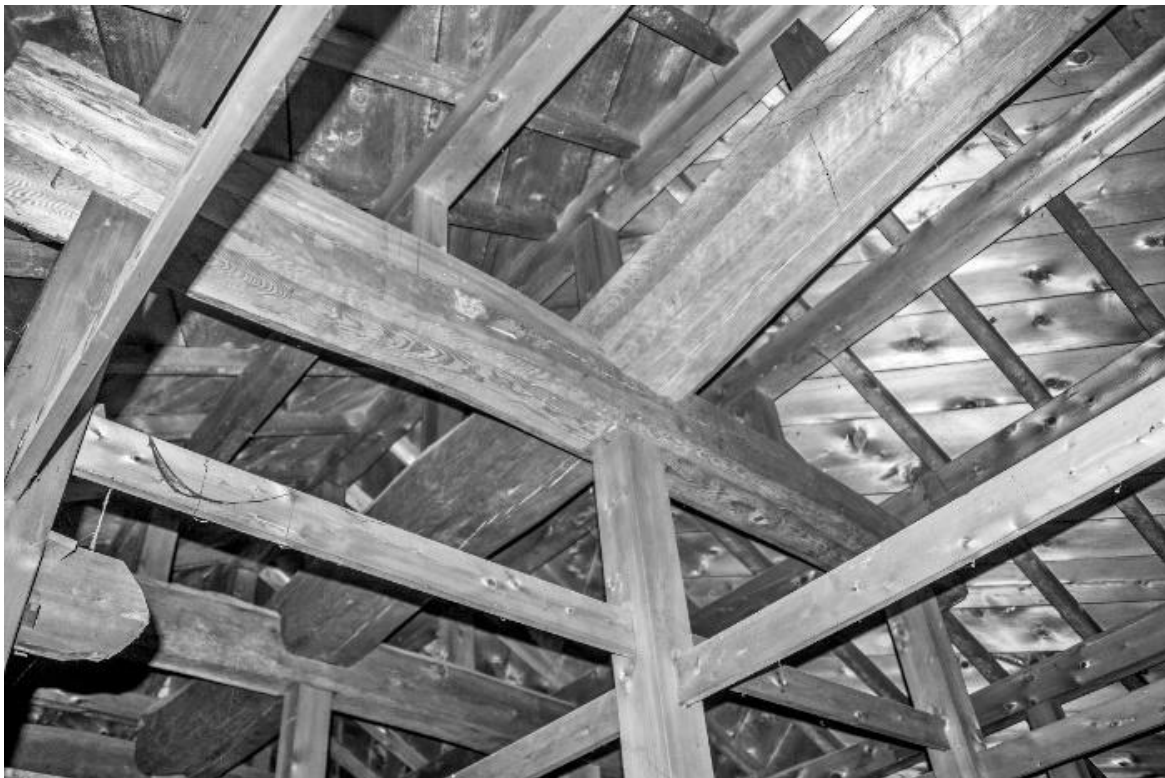
写真 2-8 斜めに張られた野地板
