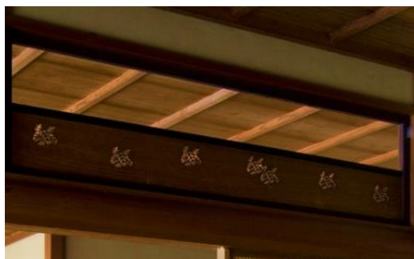
写真5-4 欄間 武者小路千家第11代一指齋宗守官休庵好み 千家十職駒沢利齋作
