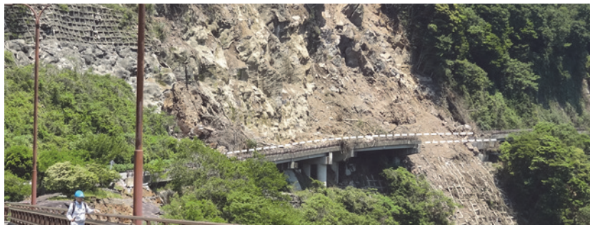
写真-1.2 2016年熊本地震にて斜面崩壊により落橋した事例
