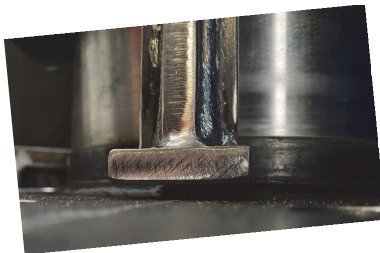
写真-4.5 損傷制御部材（杖材）の接触部
