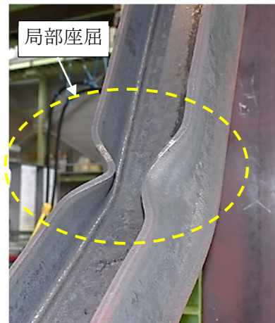
(c) ブレース材の局部座屈
